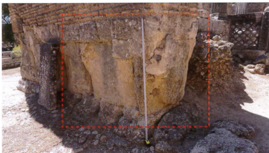
εικ. 3-1 Συμπλήρωση με τεχνητό λίθο
