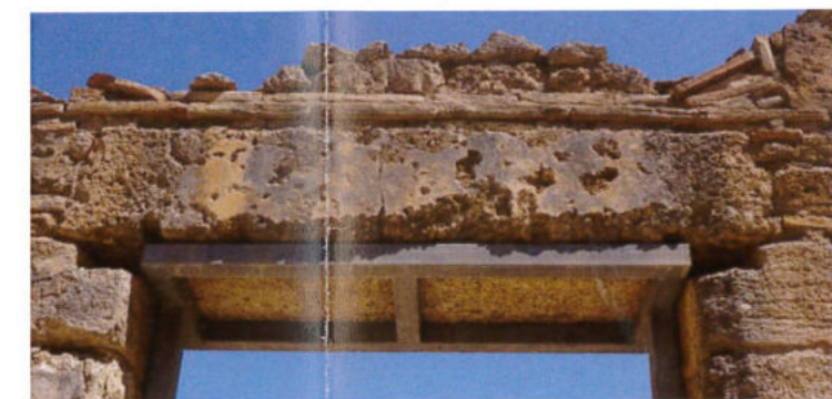
Ρηγματωμένο μονολιθικό υπέρθυρο
